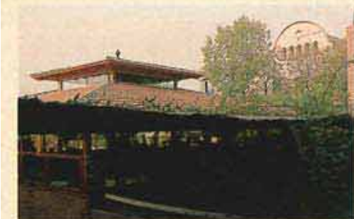
Cubierta con teja plana marsellesa en el restaurante La Balsa, de Barcelona.
