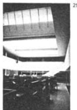
21-22. Bank Foundation en Helsinki. Alvar Aalto: Una doble claraboya que contiene en su interior la calefacción y la iluminación artificial. Al recorrer el pasillo de la planta intermedia pasamos del exterior al espacio entre claraboyas y de éste al interior.
